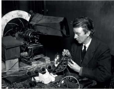
Figura 3.3 Equipo de TV mecánica de Baird (c. 1930)
