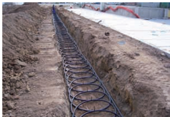
Figura 6.5: Intercambiador horizontal en bucles de tipología "slinky horizontal"
