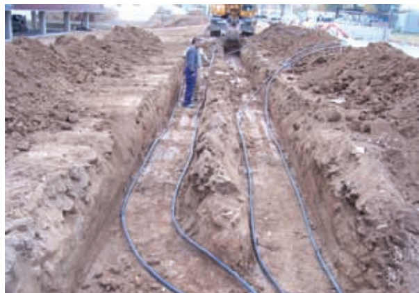
Figura 6.2: Intercambiador horizontal de lazo simple
