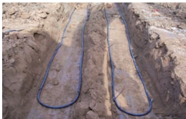
Figura 6.3: Detalle del intercambiador horizontal de lazo simple
