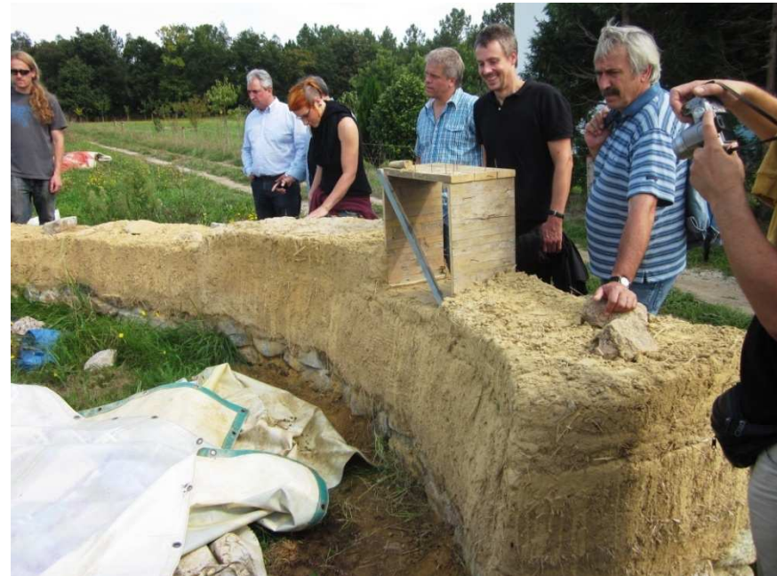
Muro de tierra con técnica COB
