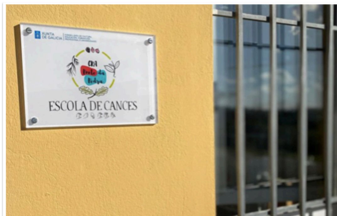
INSTALACIÓN DE CARTEIS ADAPTADOS Á LSE
