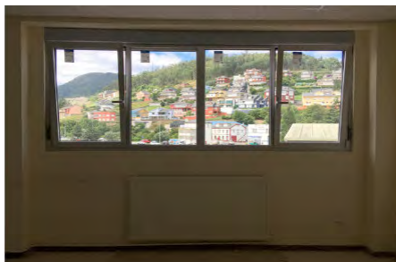
Fig. 20 Estado actual (xanela de corredeira) e estado reformado
