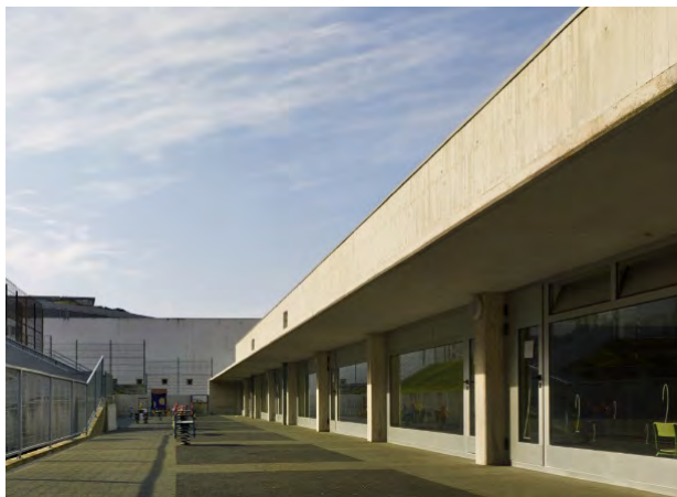
Uso do vidro para fomentar a conexión das aulas co patio. C.E.I.P. Emilia Pardo Bazán, A Coruña. Iglesias y Veiga Arquitectos.
