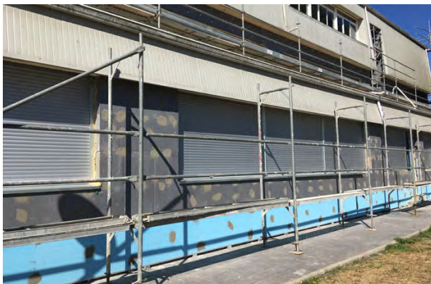
Fig. 14 Colocación SATE Fachada (zócalo de XPS e resto fachada EPS).
