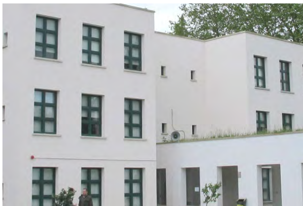
C.E.I.P. Raíña Fabiola, Santiago de Compostela. Exemplo de centro escolar próximo a centro histórico con acabado tipo revoco de cores claras e carpintería de madeira, segundo se establece na normativa.
