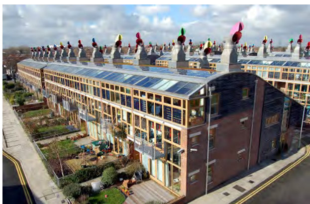
Fig. 07 Barrio de consumo case nulo (nZEB) de Sutton (Reino Unido) con sistema de extractores en cuberta
