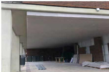
Fig. 19 Colocación illamento na cara inferior forxados en contacto co exterior (soportais).
