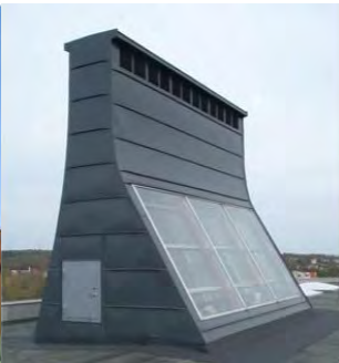
Fig. 05 Cheminea solar (zona con cristal e reixas)
