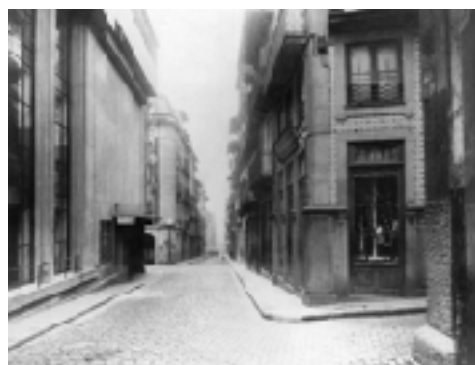
Rua do Almada em 1930. O quarteirão do lado direito foi demolido nos finais da década de 1930 e inícios da de 1940, para dar lugar à praça Dona Filipa de Lencastre. Esta abertura esteve enquadrada num plano de monumentalização que acompanhou a construção da avenida dos Aliados e do novo edifício da câmara.
