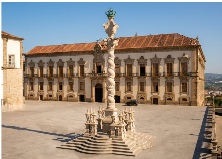
Paço Episcopal e pelourinho, no recém-aberto terreiro da Sé, 1945. O Paço Episcopal é um edifício barroco, erguido no lugar do antigo paço medieval. Nicolau Nasoni deixou aqui a sua marca, projetando três fachadas distintas. O edifício sofreu estragos sérios aquando do Cerco do Porto (1832-1833) e, com a implantação da República, passou para as mãos do Estado. Entre 1916 e 1957 foi Câmara Municipal do Porto. O terreiro da Sé só adquiriu o aspeto que hoje tem em 1940, quando foi demolido o casario medieval que aqui se localizava, ampliando grandemente o pequeno terreiro que então existia. Em primeiro plano, um pelourinho em forma de coluna salomónica. Apesar da aparência antiga, trata-se de um mero ornamento, feito pela Cooperativa dos Pedreiros e aqui colocado em 1945. Foto de Guilherme Bonfim Barreiros
