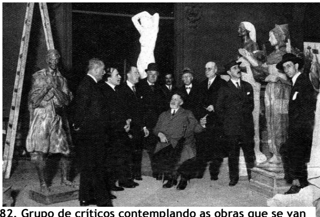
82. Grupo de críticos contemplando as obras que se van exhibir na Exposición de 1926. Á dereita da imaxe apréciase o S. Francisco
