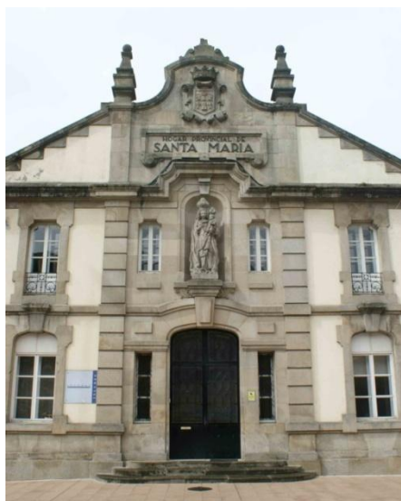
174. Antigo Hospital de Santa María, coa virxe de Asorey na parte central da fachada.
