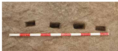
Marcas e cuñeiras de canteiro.
