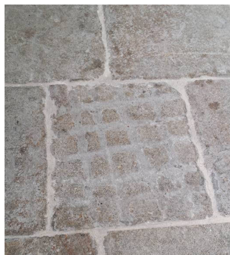
Reticulado do Convento de San Francisco. Foi cementado despois de localizado no 2015.
