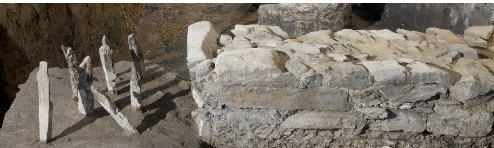
Restos do sistema de cimentación para terreos brandos do século XVIII descuberto nos sotos do edificio do Banco de España
