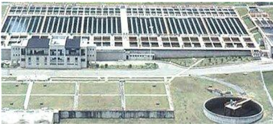
Vista superior dunha EDAR (Estación Depuradora de Augas Residuais)
