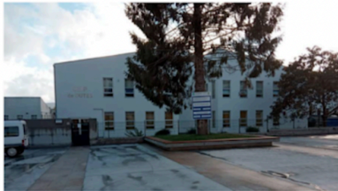
Fachada do CEIP Plurilingüe de Outes. Foto: ECG
