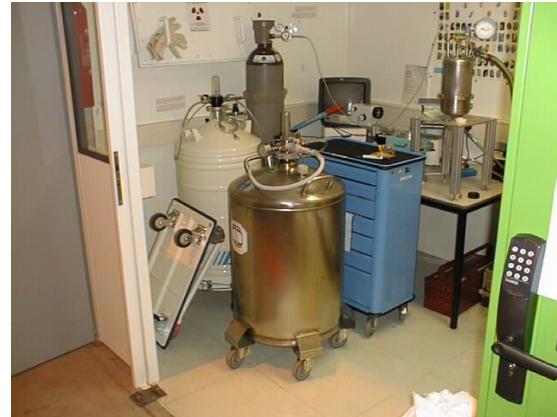
TANQUE DE NITRÓXENO LÍQUIDO
