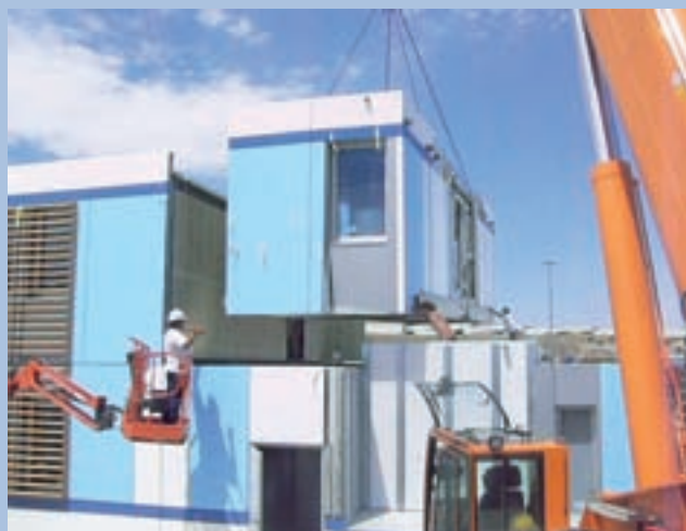
La construcción del hotel I-Sleep se realizó en apenas dos meses.
