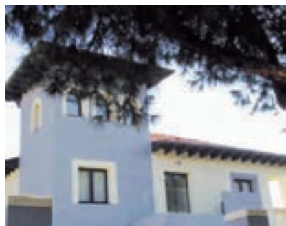
Fachada de la escuela Tracor.
