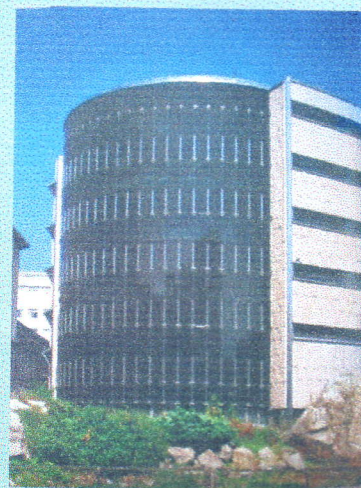
Edificio dos xulgados Semicilindro
